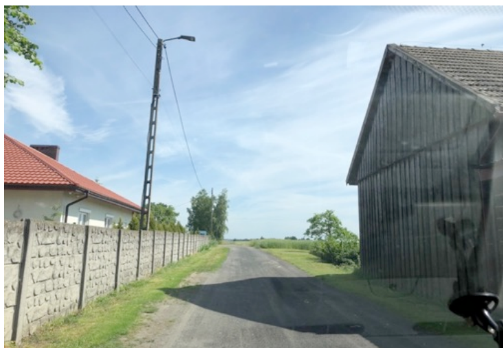
Lipie zadanie 7.59. Dowieszenie oprawy LED wraz z budową zasilania w miejscowości Zimnowoda posesja 3 -ZIMNOWODA
